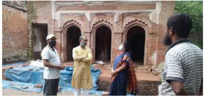
পানাম নগরের ১৩নং সংস্কার কাজ পরিদর্শন
